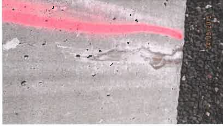
Bsp: Rissbildung in Betonkappen der Brückenbauwerke
