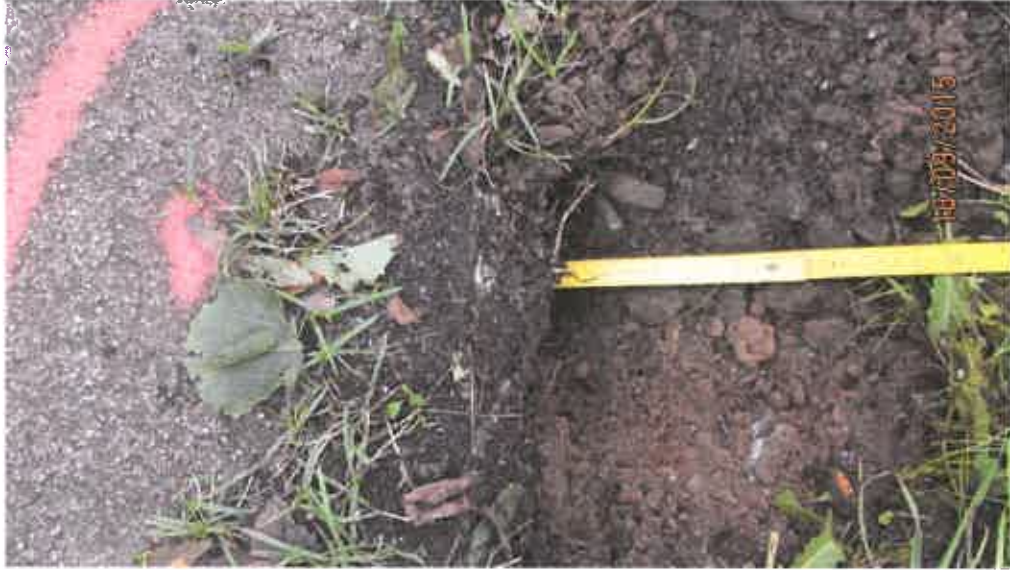
Punkt 17 = 8cm (Wurzeleinwuchs)
