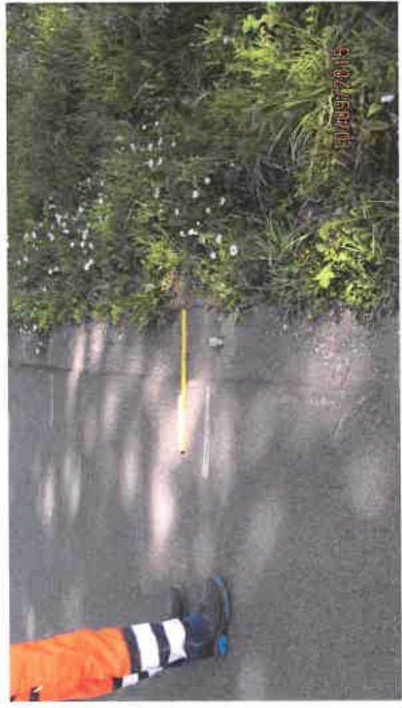
Bsp: bituminöse Tragschicht abwechselnd breiter als Deckschicht
