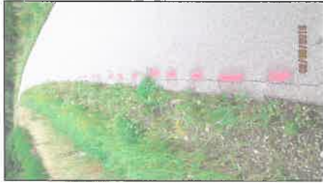
Abb. Längsriss, -
