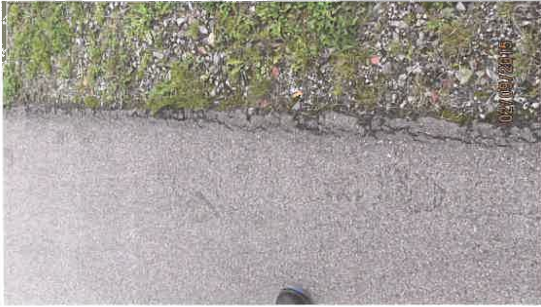
Bsp: fehlender Kantendruck am freien Rand
