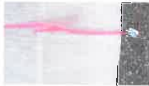
Abb. Durchgehende Querrisse auf der Brückenkappe an nahezu allen Montagepunkten der Geländerpfosten
