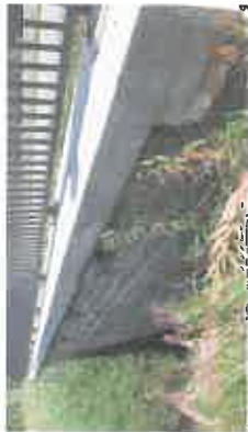
Abb. Massive Quer- und Längerrisse in der Brückenkappe
