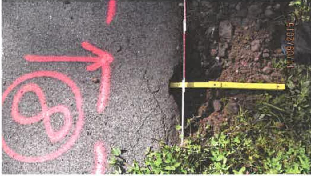
Punkt 8 = 11cm (Risse)
