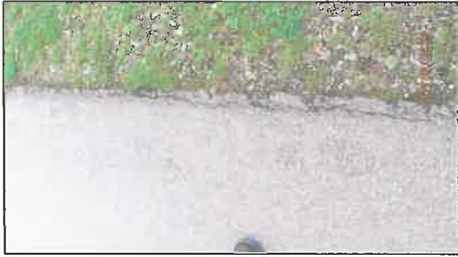
Fehlender Kantenandruck
