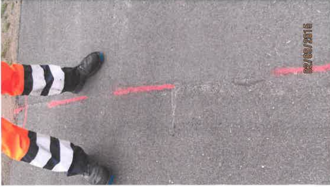
Bsp: unebene Fahrbahnoberfläche
