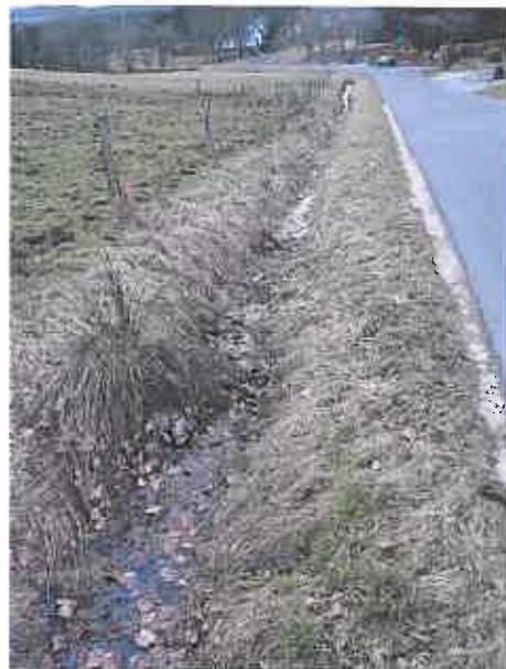
Abb. 4: Straßenseitengraben (von Monschauer Hecke bis zu Einmündung "In der Vlötz")
