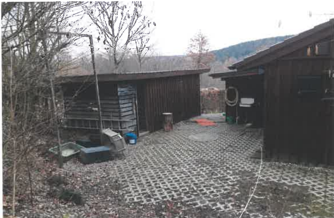
Nördliche Nebengebäude an Jagdhütte (Quelle: KRINGS, ARCHITEKTUR+STADTPLANUNG)
