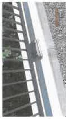
Abb. Massive Quer- und Längerrisse in der Brückenkappe
