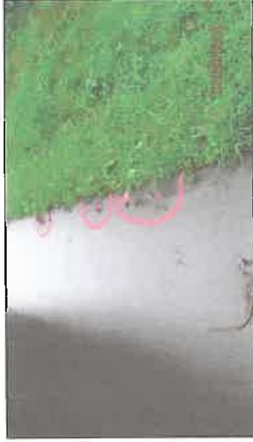
Ein weiterer erheblicher Grund für den Pflanzenwuchs durch die Deckschicht liegt am fehlenden Schichtenverbund zwischen Trag- und Deckschicht. Eine Erklärung hierfür könnte eine unsachgemäße Verschmutzung der Tragschicht (z.B. infolge verdreckter Fahrzeugbereifung oder eingetragenen Schmutz vom Bankettbereich) sein, welche vor dem Aufbringen des Haftklebers nicht ordnungsgemäß gereinigt wurde.
