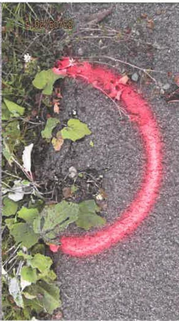
Bsp: Arten des Pflanzendurchwuchses durch die bituminöse Deckschicht
