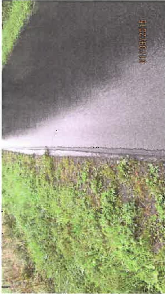
Bsp: bituminöse Tragschicht abwechselnd breiter als Deckschicht
