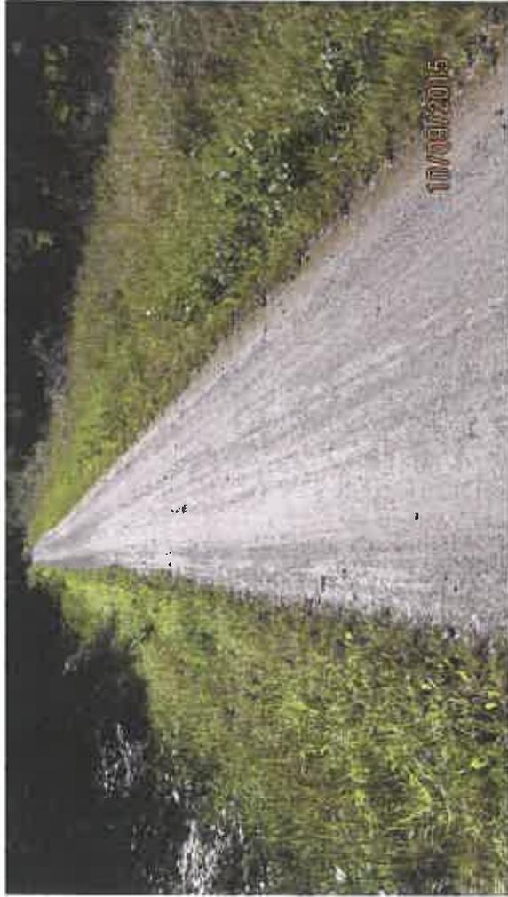
**Bsp: wassergebundene Deckschicht (Spurrillen)**
