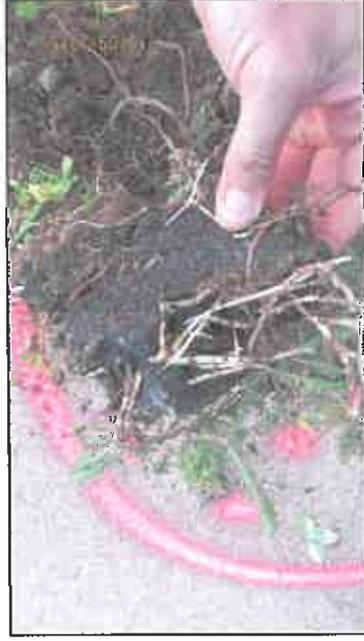
Abb: Wurzeldurchwuchs zwischen Trag- und Deckschicht
