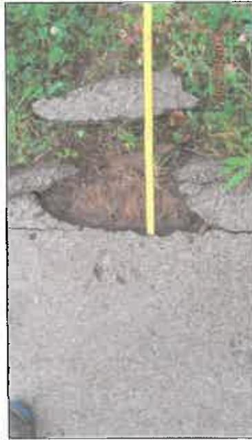
Abb.: Bsp. 16cm fehlende Tragschicht unter der Deckschicht
