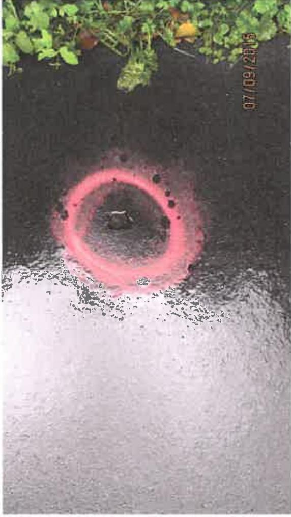
**Bsp: Fehlstelle in der bituminösen Deckschicht**
