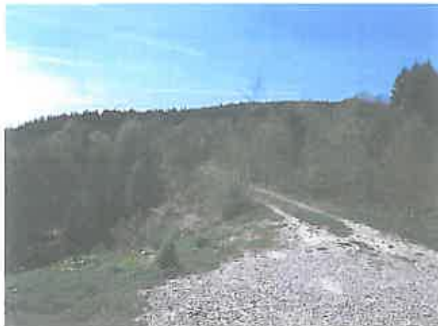
5. Zufahrt zum Kloster Reichenstein aus südwestlicher Richtung über einen Damm.
