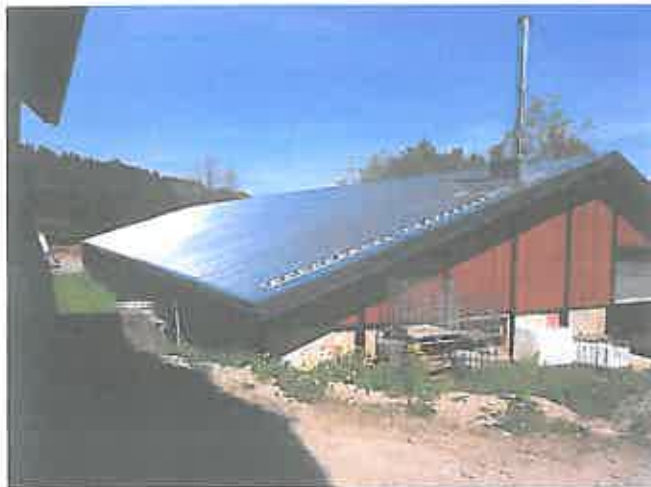
17. Blick aus südlicher Richtung auf das Dach des jüngeren Nebengebäudes (vgl. Abb. 16).
