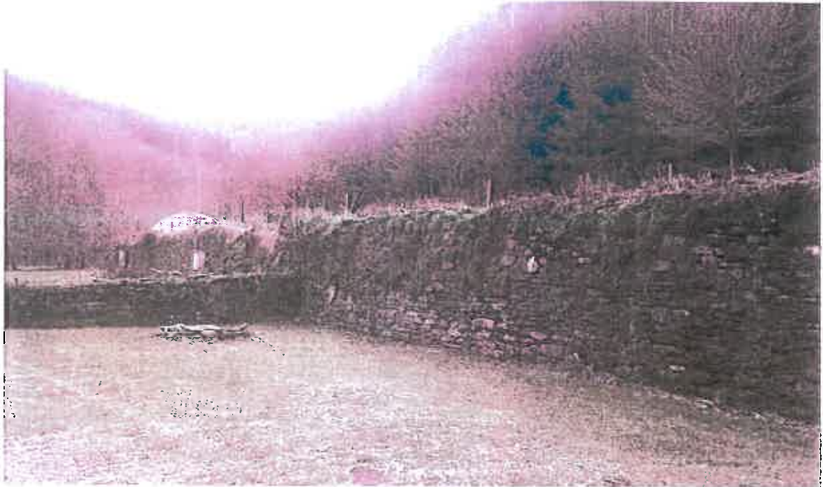
Abb. 4 Teichmauer mit dahinter liegendem aufgeschütteten Stauteich.
