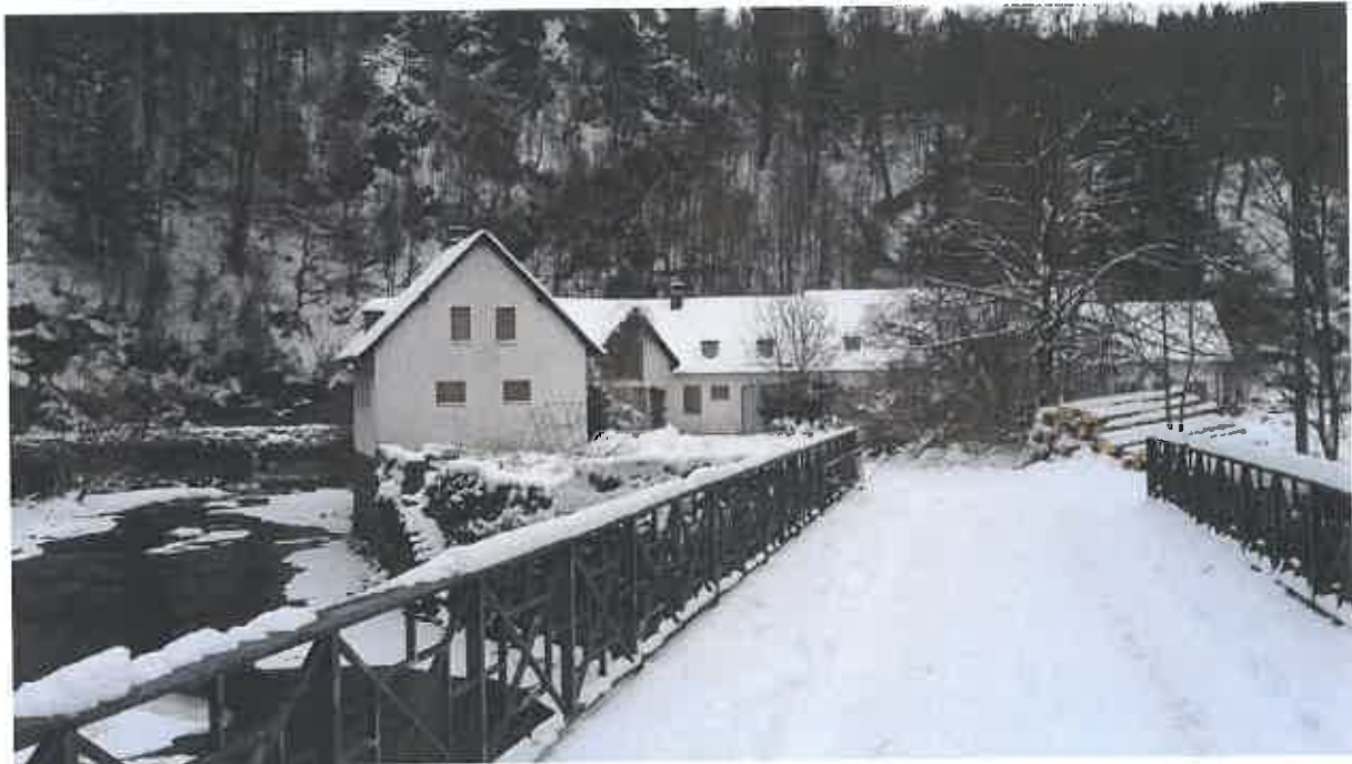
Ehemaliges Betriebsgebäude / Blick von der Zufahrtsbrücke
