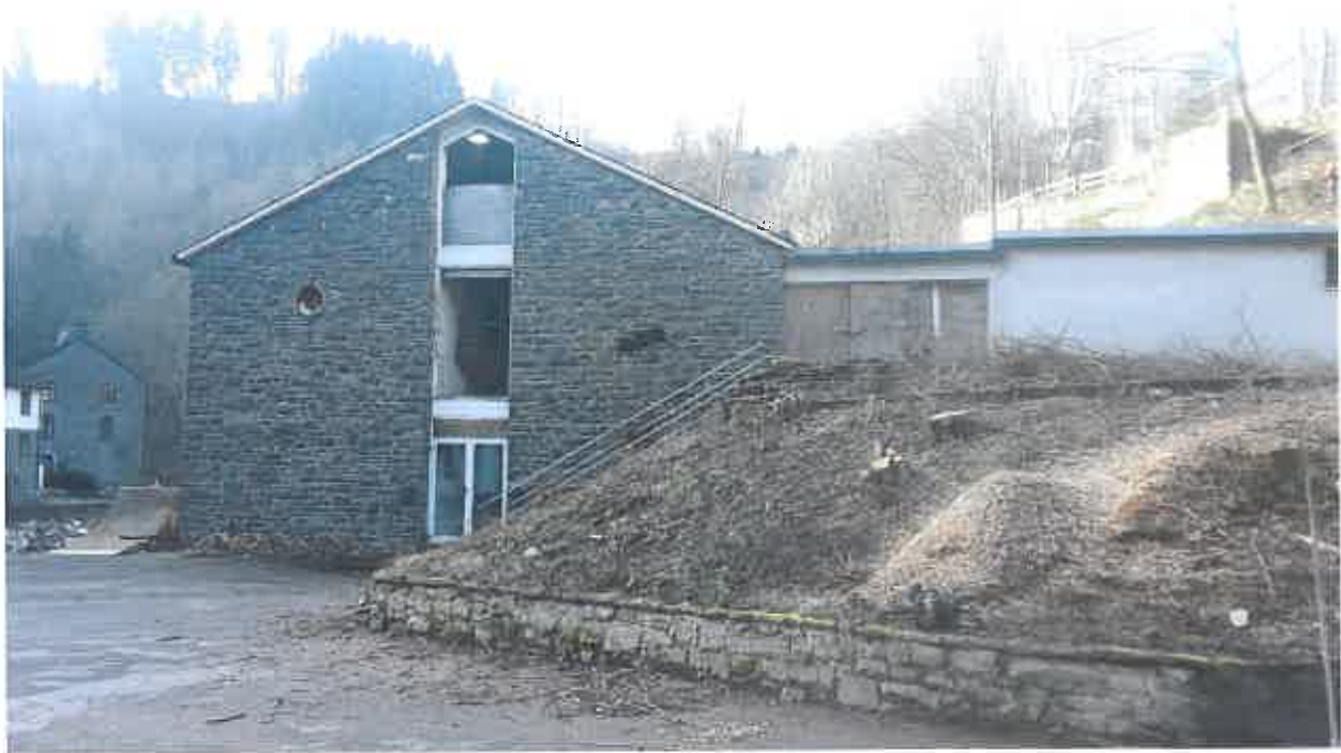
Ehemaliges Verwaltungsgebäude / Nord – Ost – Seite
