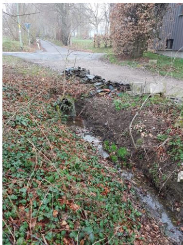
Abb. 5 – Entwässerungsgraben verrohrt, (Flurstück 360, Blick zum Kirschensteinweg)
