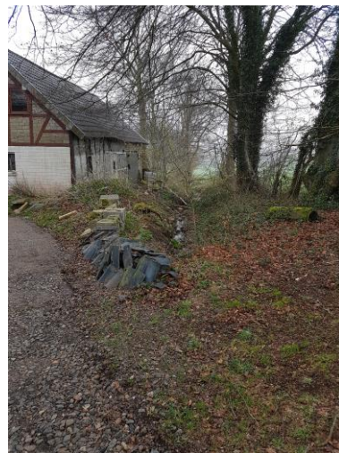
Abb. 6 – Entwässerungsgraben, offener Graben (Flurstück 360, Blick in Fließrichtung)
