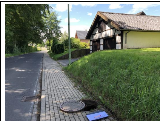
Abb. 3 – Entwässerungsgraben im Gehweg des Kirschensteinwegs, verrohrt (Blick in Richtung Eupener Straße)
