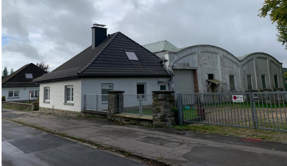
Westliche Bebauung - Gewerbeimmobilie (Quelle: KRINGS ARCHITEKTUR+STADTPLANUNG)
