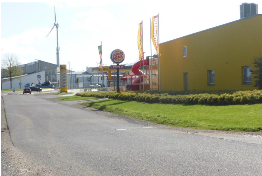
Abbildung 3 Baustraße (Erschließungsstraße) – Blick Richtung Kreisverkehr
