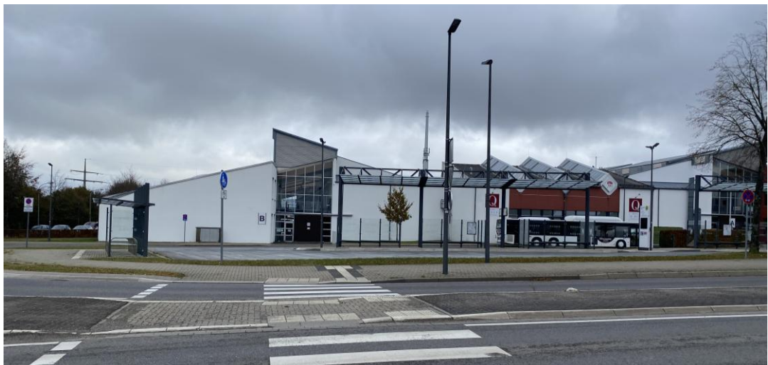
Abbildung 3: Zentralen Omnibusbahnhof im Ortsteil Imgenbroich
